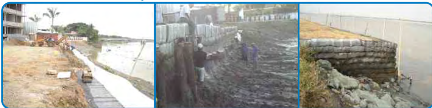
Fotografías 1, 2 y 3. Construcción de muro en suelo reforzado con geomallas FORTGRID®
