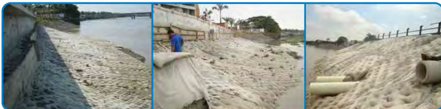
Fotografías 4, 5 y 6. Revestimientos de orillas con COLCHACRETO® FP T
