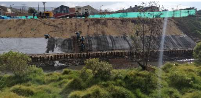
Foto 4. Colocación del concreto mediante bombeo en la formaleta textil Colchacreto Articulado.
