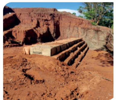
Control de erosión Pacora - Panamá.
