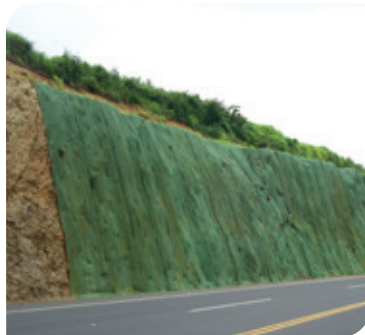
Control de erosión San José - Costa Rica.
