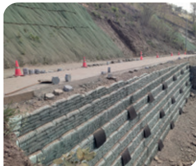
Muro en suelo reforzado Telpaneca- Nicaragua.
