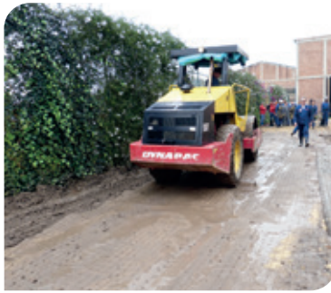
Soporte de pavimentos sobre suelos blandos Bogotá - Colombia.
