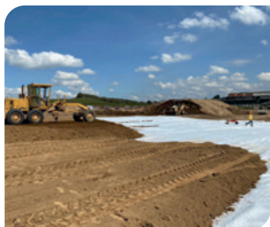
Refuerzo de subrasante Guatemala.
