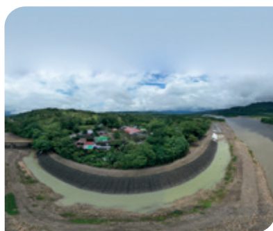
Protección de orillas Upía - Colombia.
