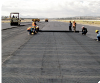
Refuerzo de carpeta asfáltica Latacunga - Ecuador.
