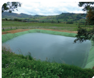
Revestimiento de lagos y reservorios Cundinamarca - Colombia.
