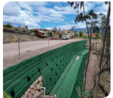
Muro en suelo reforzado Azuay - Ecuador.
