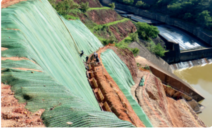
CONTROL DE EROSIÓN
