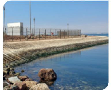
Control de Erosión Paracas - Perú.
