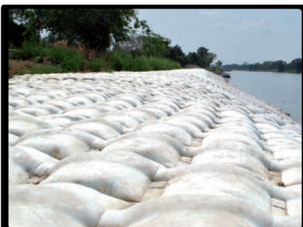
Fotografía 1. Revestimiento con COLCHACRETO ARTICULADO
