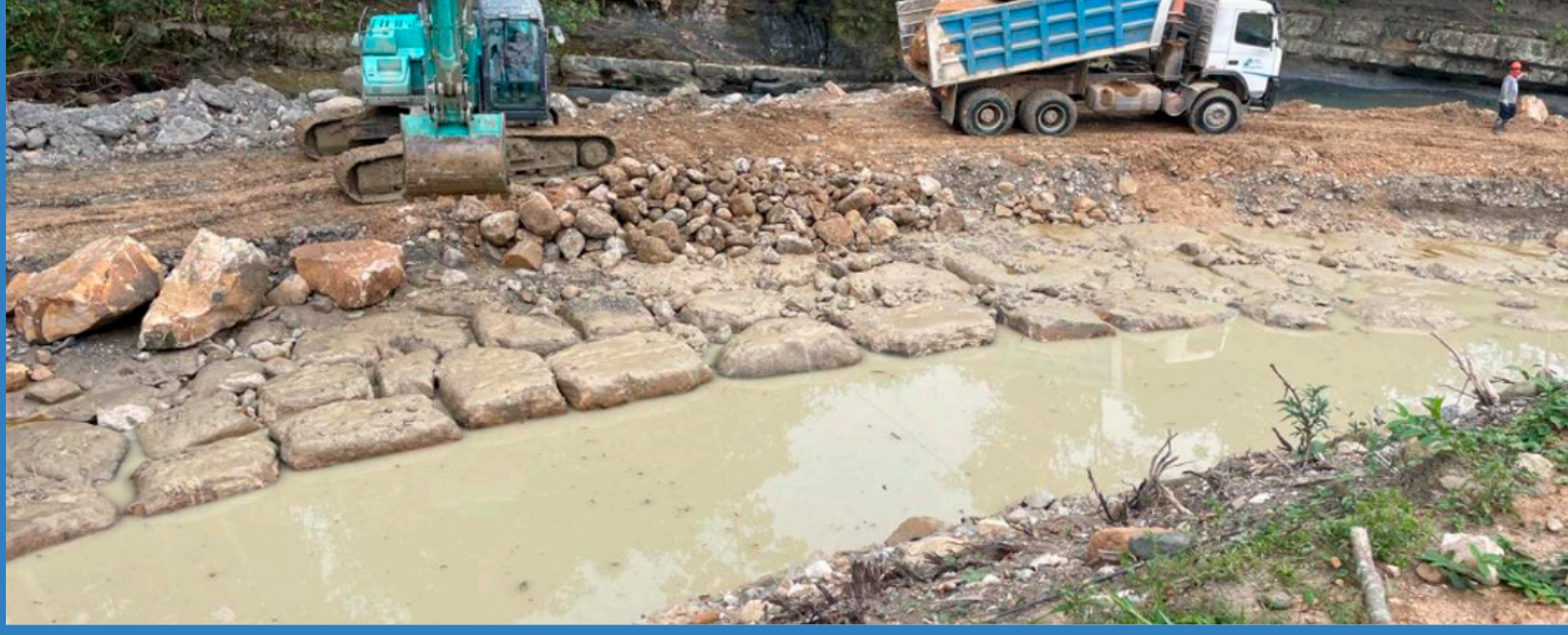
Fotografía 1. Aspecto de la obra antes del uso de geosintéticos de Geomatrix
