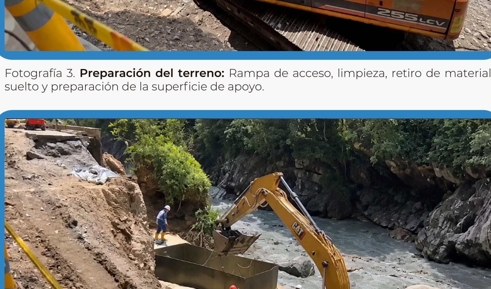
Fotografía 3. Preparación del terreno: Rampa de acceso, limpieza, retiro de material suelto y preparación de la superficie de apoyo.
