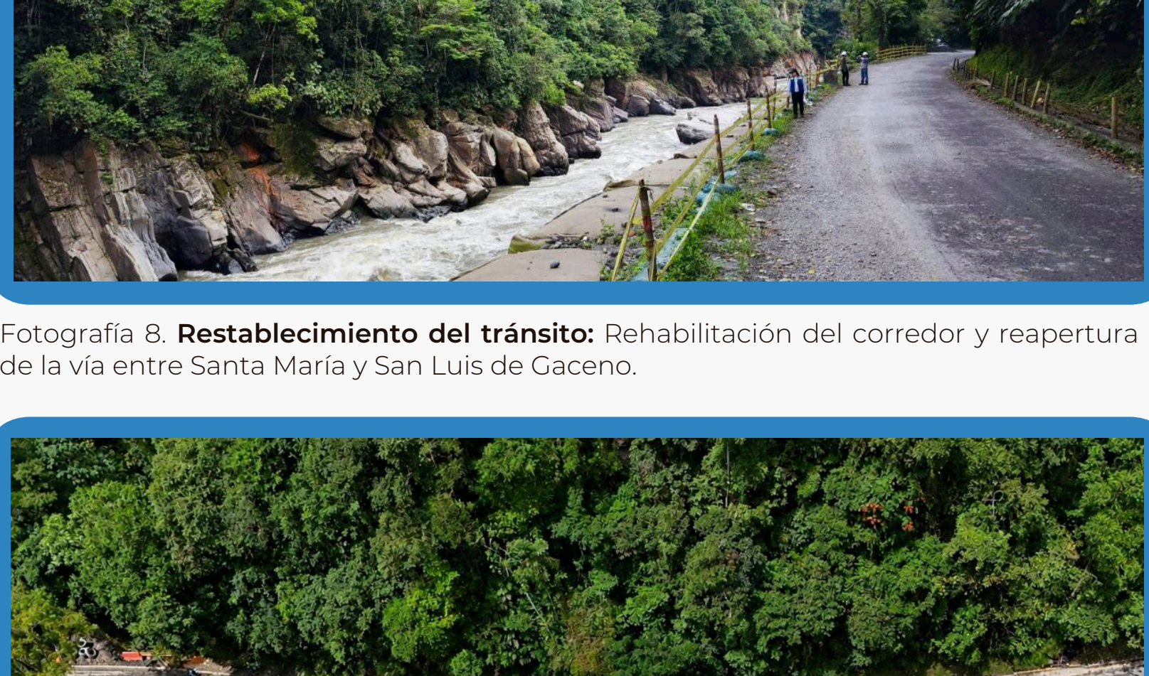
Fotografía 8. Restablecimiento del tránsito: Rehabilitación del corredor y reapertura de la vía entre Santa María y San Luis de Gaceno.
