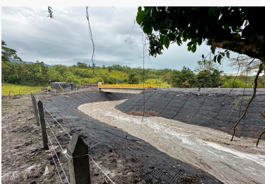
Fotografía 10. Proyecto terminado (vista lateral).
