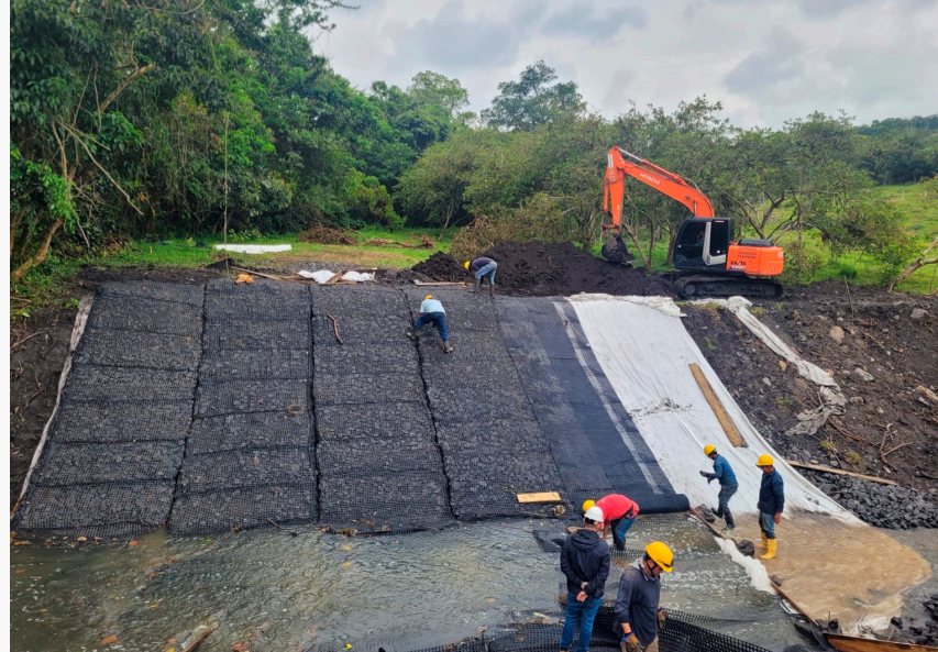
Fotografía 7. Amarre entre módulos.
