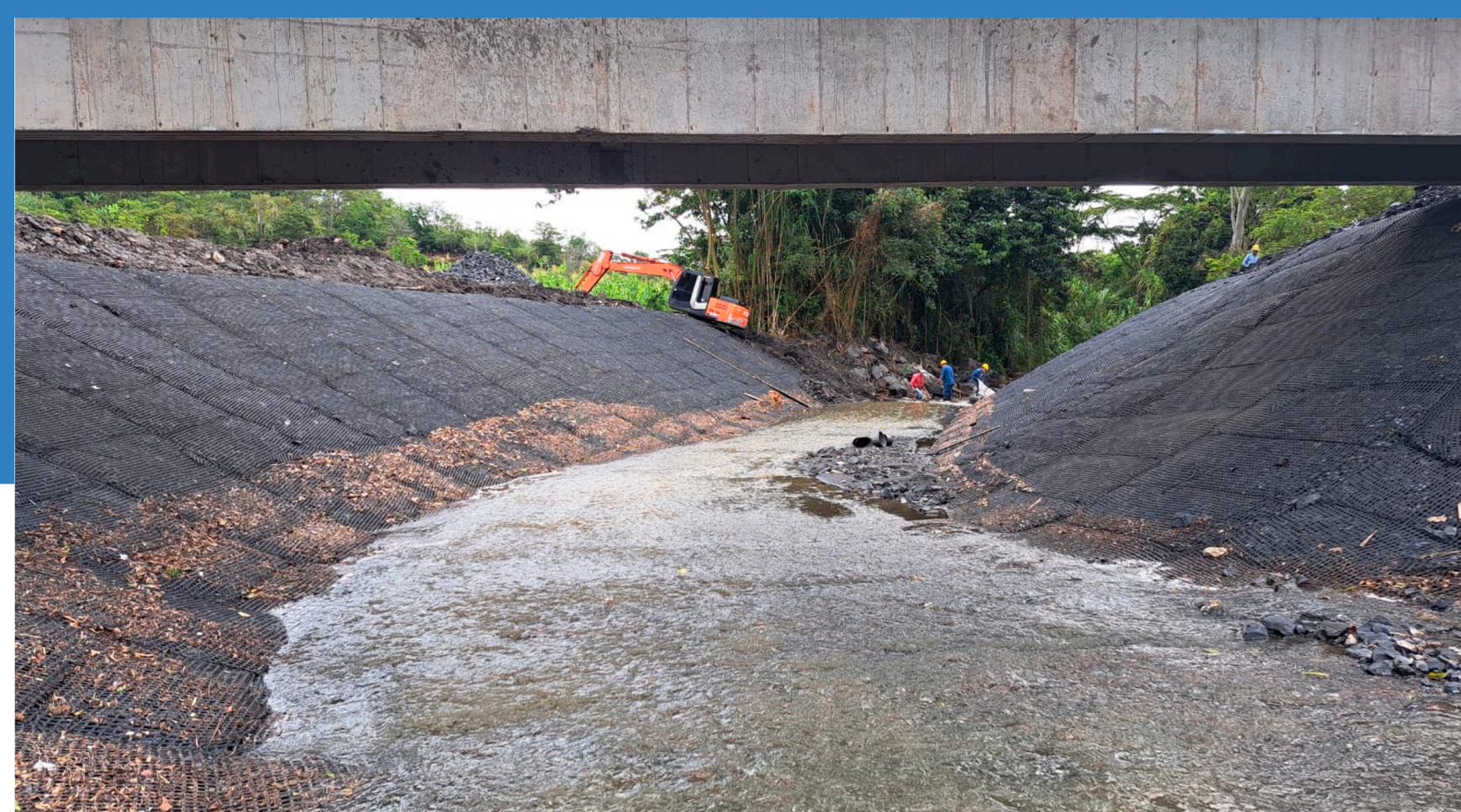
Fotografía 8. Panorámica del cauce protegido.
