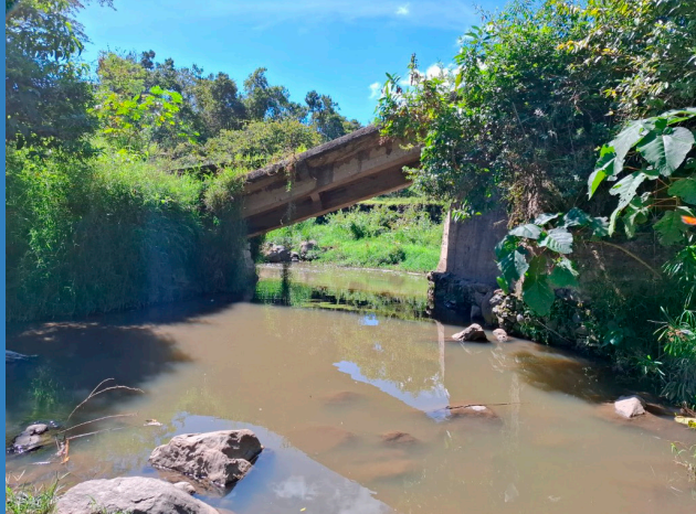
Fotografía 2. Vista lateral del puente y el cauce.
