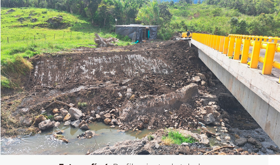
Fotografía 4. Perfilamiento de taludes.
