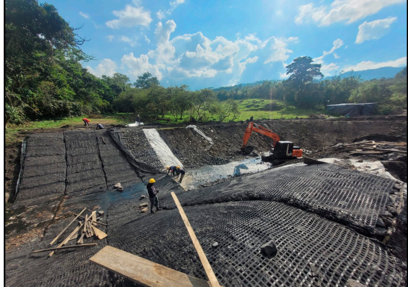
Fotografía 6. Llenado de los colchones de enrocado confinado con Hidromalla Geoestera 50.
