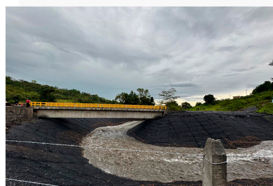
Fotografía 9. Proyecto terminado visto desde aguas abajo del puente.
