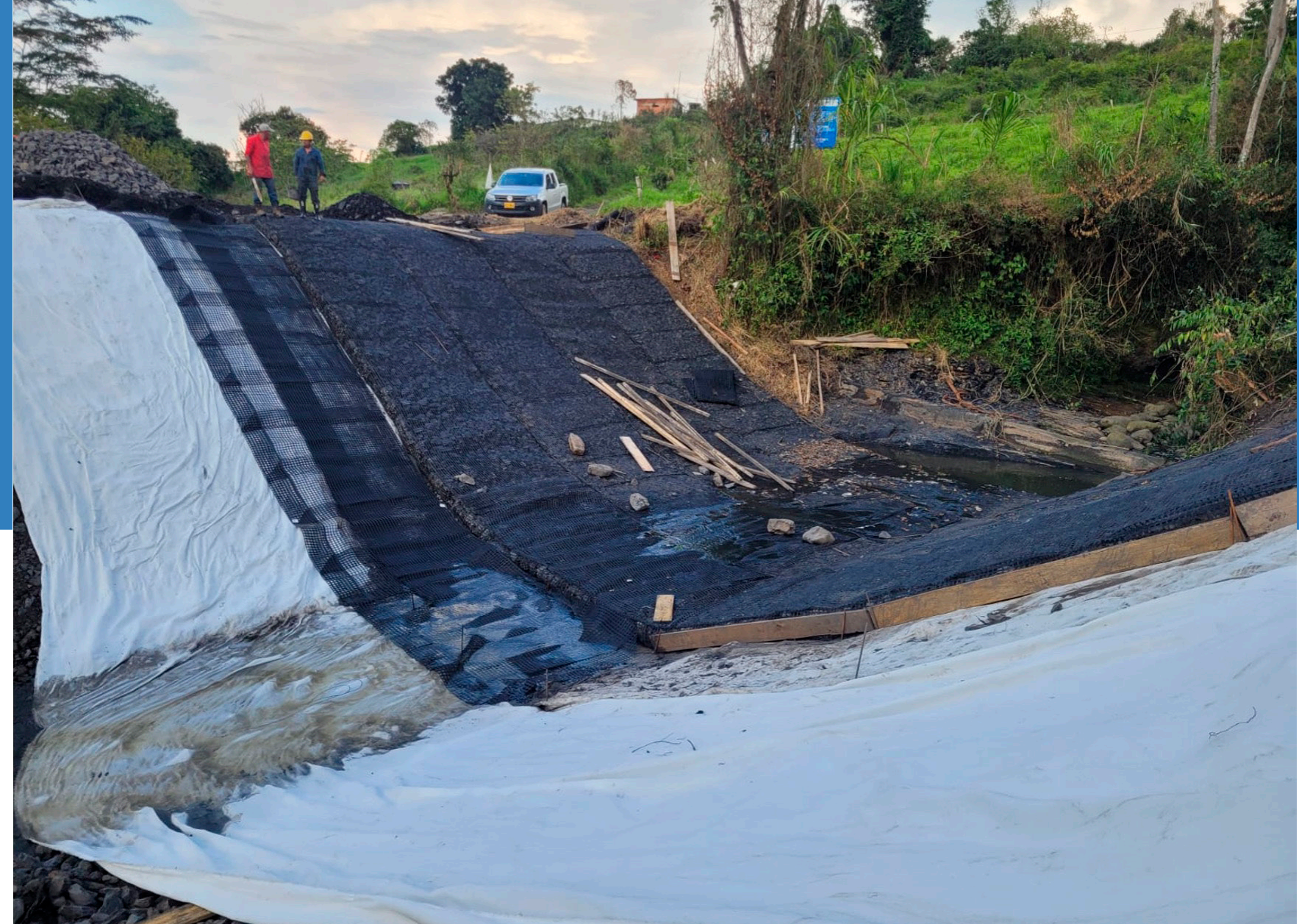
Fotografía 5. Instalación del geotextil y colchones de enrocado confinado con Hidromalla Geoestera 50.
