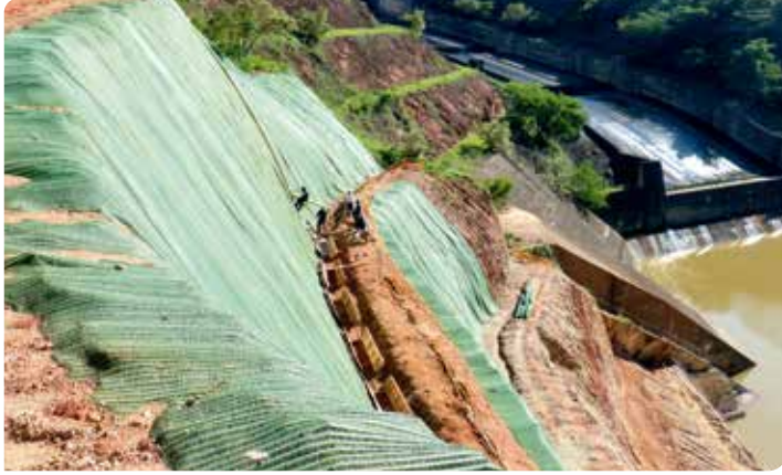
CONTROL DE EROSIÓN
