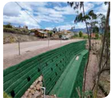
Muro en suelo reforzado Azuay - Ecuador.
