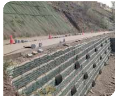
Muro en suelo reforzado Telpaneca - Nicaragua.
