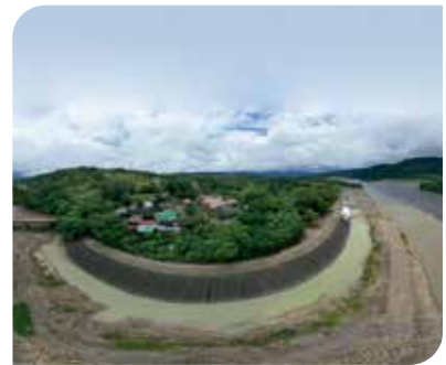
Protección de orillas Upía - Colombia.
