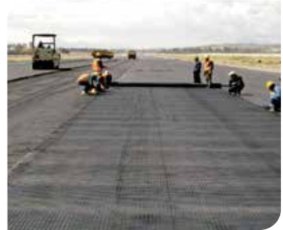
Refuerzo de carpeta asfáltica Latacunga - Ecuador.
