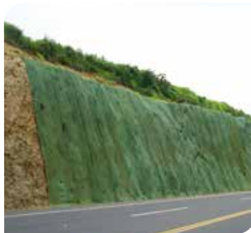
Control de erosión San José - Costa Rica.
