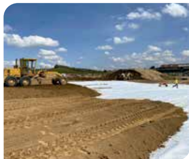
Refuerzo de subrasante Guatemala.
