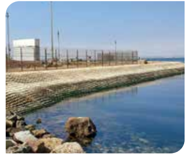
Control de erosión Paracas - Perú.
