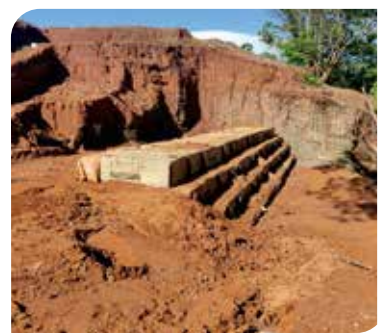
Control de erosión Pacora - Panamá.
