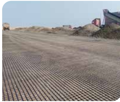
Refuerzo de base granular Puerto del Callao - Perú.
